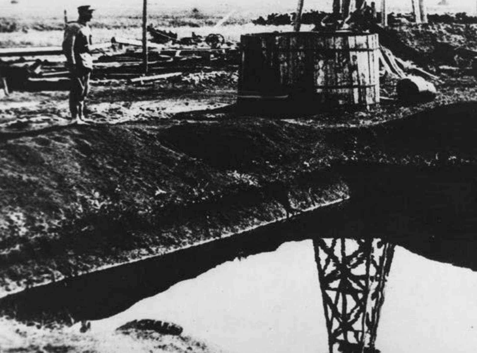
Первое время для сбора и хранения нефти рыли глубокие котлованы.
