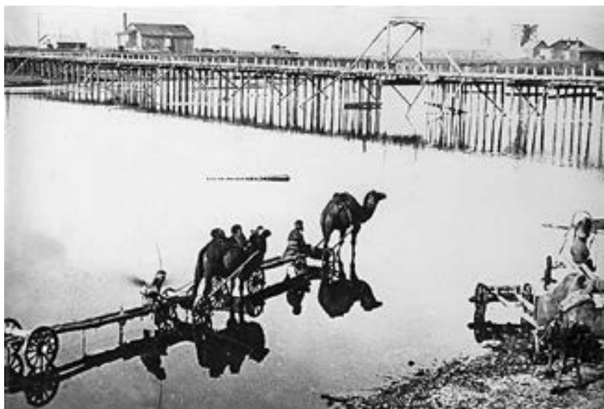
Временный мост через реку Белая.
