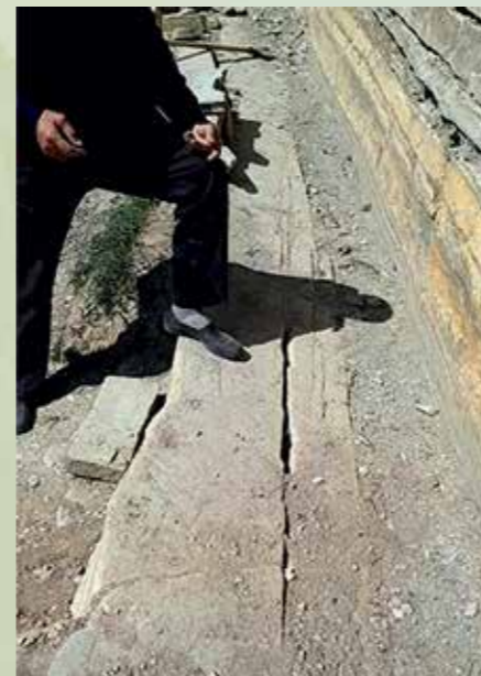
Забитые штроба (крепежи для укрепления деревянных досок)
