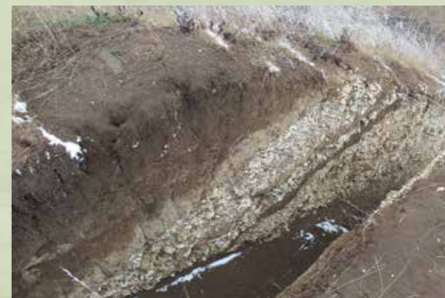
Фото с объекта: срез ограждения, сделанного вокруг чернозёма в виде водосборного дренажа высотой 10 метров и шириной до 100 метров, под углом 12 градусов направленное в центр объекта
